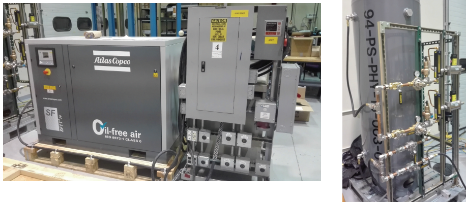
Figure 13: Compressore di aria secca (a sinistra) e serbatoio e linea di aria compressa (a destra).
