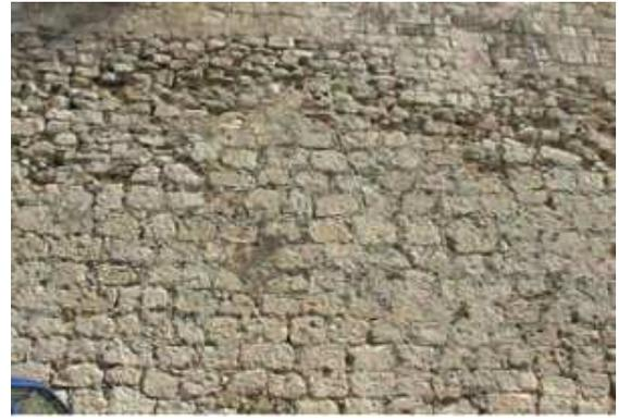
Figura 14.4 Abside della Chiesa Rossa a Milano: la parte scura (più fredda) evidenzia la presenza di risalita capillare di acqua dal sottosuolo
